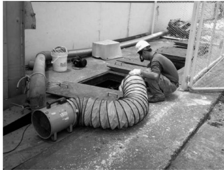
图 4-6 风机、风管的设置
