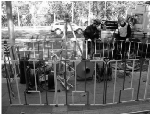
图 4-2 作业现场围挡
