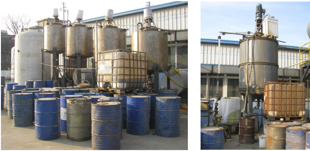
(b) 废有机溶剂的预处理单元
